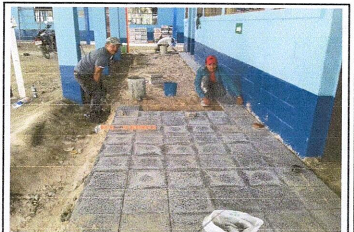
Foto 4: Mejoramiento de piso granito modulo 2
