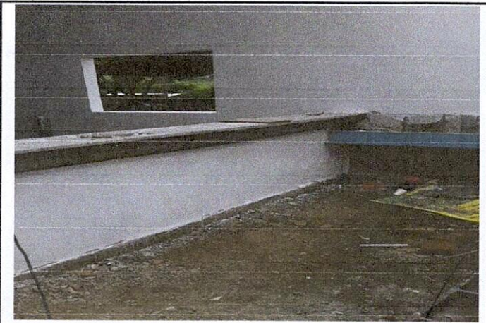
Foto 3: Mejoramiento de cocina
