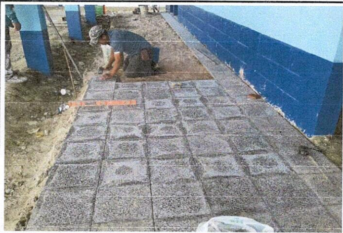
Foto 3: Mejoramiento de piso granito modulo 2
