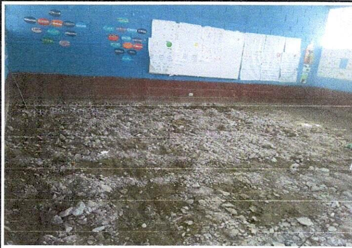
Foto 1: Mejoramiento de piso granito modulo 2
