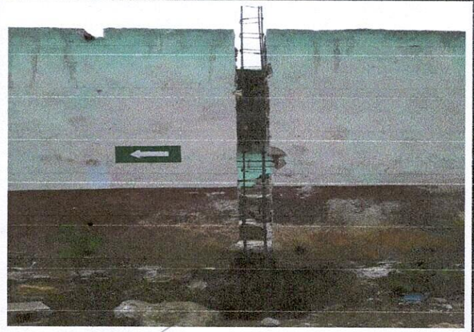
Foto 2: Mejoramiento de cocina
